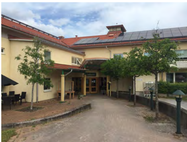
Bild 13: Vård- och omsorgsboendet Solrosen med uppstickande byggnadsdel synlig i bild.
