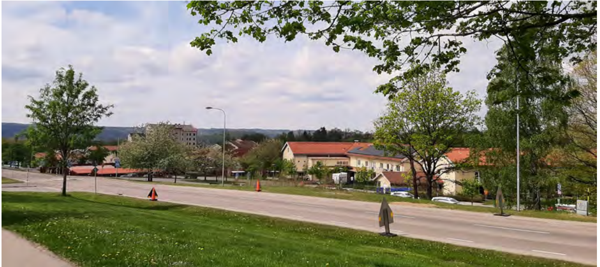
Bild 19: Vy mot fastigheten sett från Tre Rosors väg öster om planområdet.
