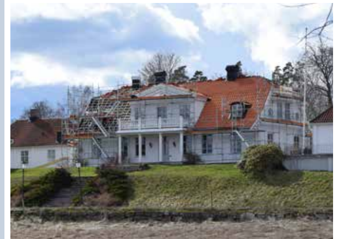
Säteriets huvudbyggnad, östra fasaden.
