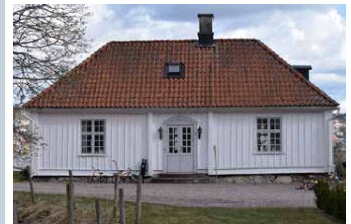
Sydvästra flygelns entré. De fyra flyglarna har i princip likadan fasadutformning, restaurerade i nyklassicistisk prägel 1941.
