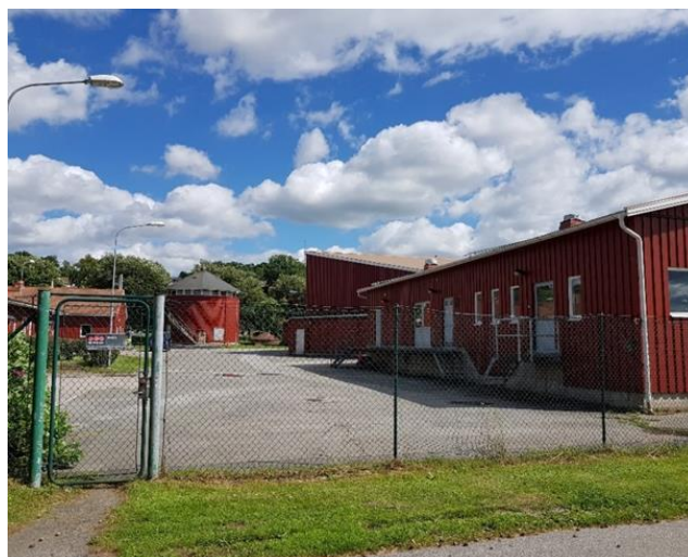
Bild 1. Nuvarande reningsverk vid Brunnsbo/Fiskebacken.
