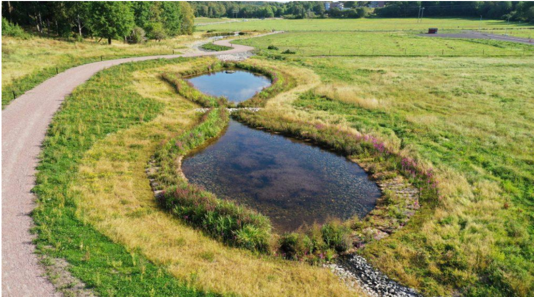
Figur 15. Dagvattendamm uppdelat i två sedimenteringsdelar med en grundzon mellan. Källa: Östersunds kommun, 2021-04-20.
