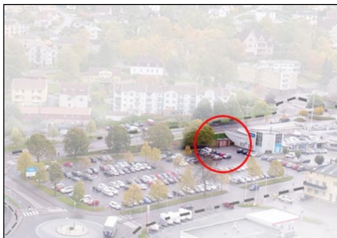
Bild 6. Befintlig byggnad inom fastigheten Bogesund 1:86, planområdets sydöstra del.
