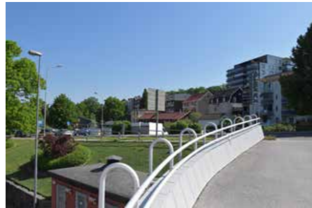
4. Befintlig WC-byggnad fotograferad från ramp vid Tullen 10.
